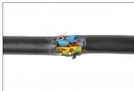
Beschadigde elektrische kabel
