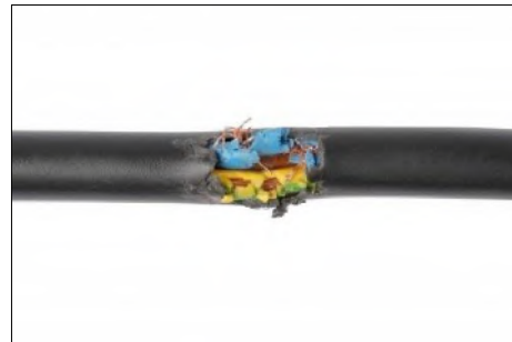
Beschadigde elektrische kabel
